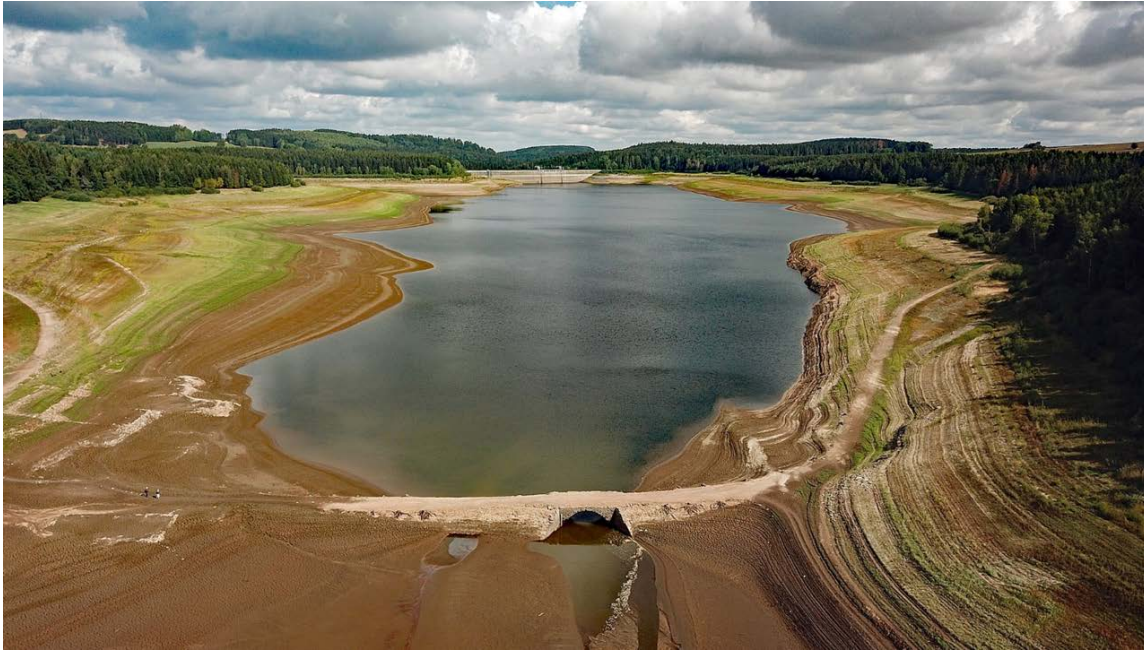
Abbildung 85: Restwasserkörper und freiliegende Sedimentareale der im August 2018 stark abgesenkten Talsperre Lehmühle; Bildquelle: Wikipedia, Foto: Gunther Tschuch, CC BY-SA 4.0 ( https://creativecommons.org/licenses/by-sa/4.0/deed.de )
