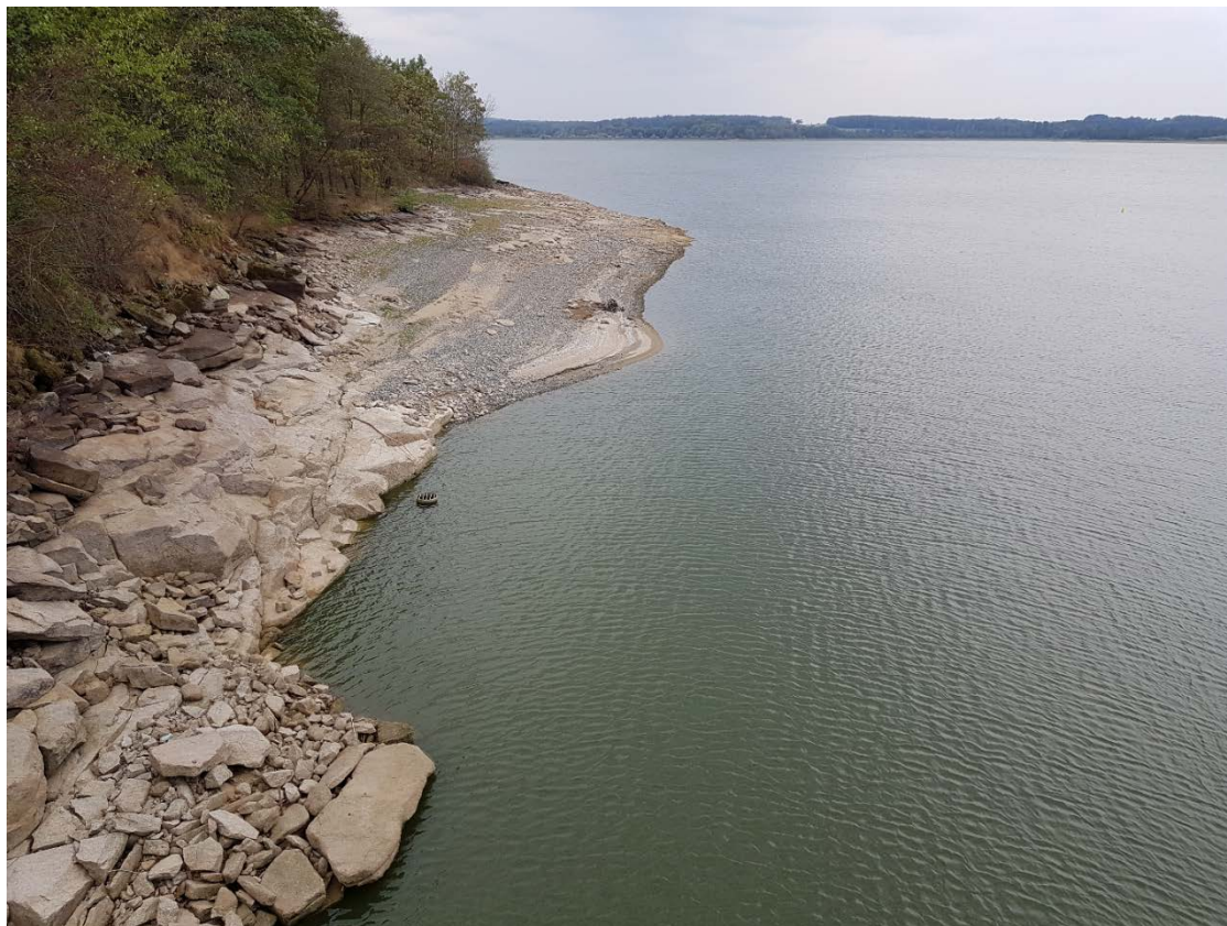
Abbildung 65: Talsperre Bautzen mit freiliegendem Uferbereich im September 2018. Foto: LTV
