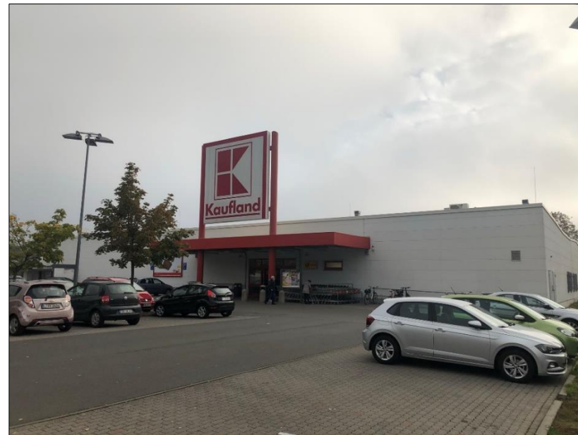
Abb. 2: Bestehender Verbrauchermarkt an der Portitzer Straße
