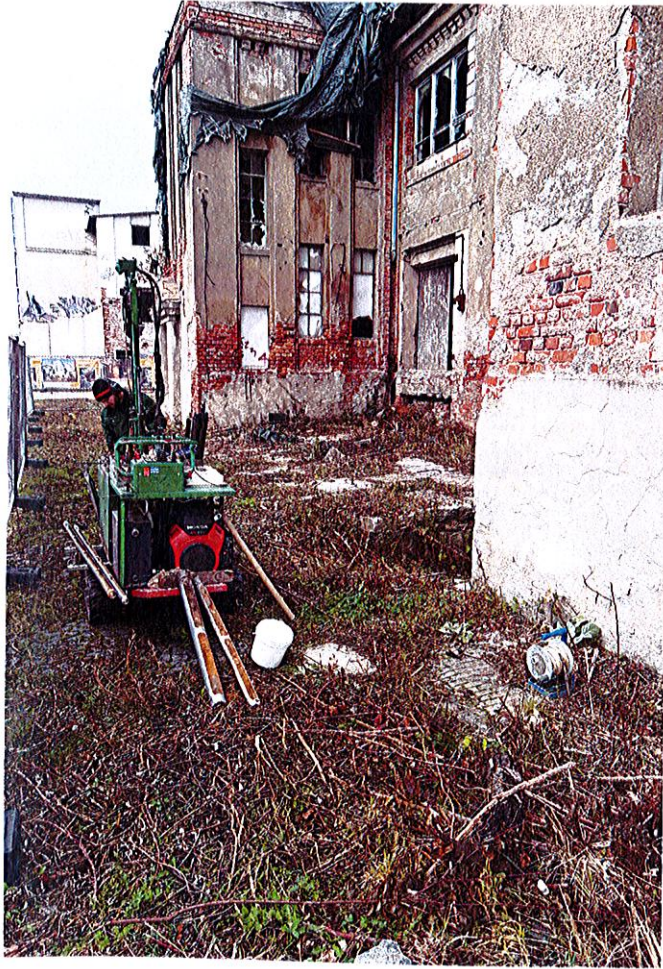
RKS 1 Südseite Turmhaus
