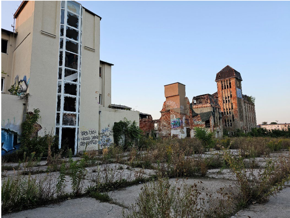
Abbildung 18: Im Turm der alten Emailierfabrik brütete im Jahr 2024 ein Paar des Turmfalken (27.08.2024).
