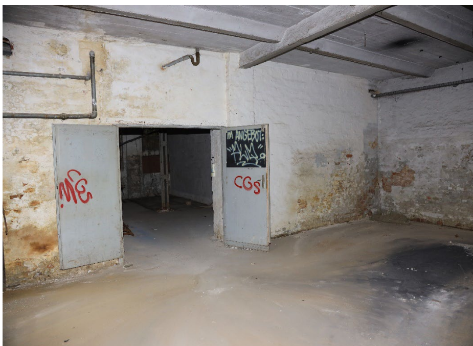
Abbildung 13: Kellerraum unter dem Hauptgebäude (10.11.2022).
