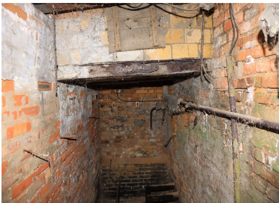
Abbildung 11: Keller- raum unter dem alten Kesselhaus (10.11.2022).
