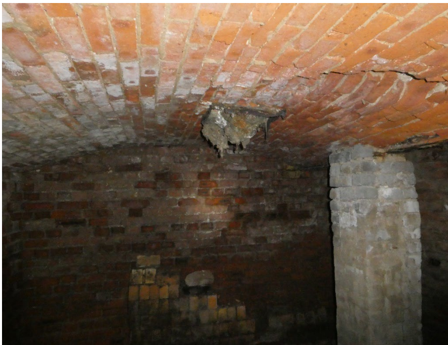
Abbildung 7: Blick in einen der Gewölbekeller unter dem alten Kesselhaus (13.03.2024).
