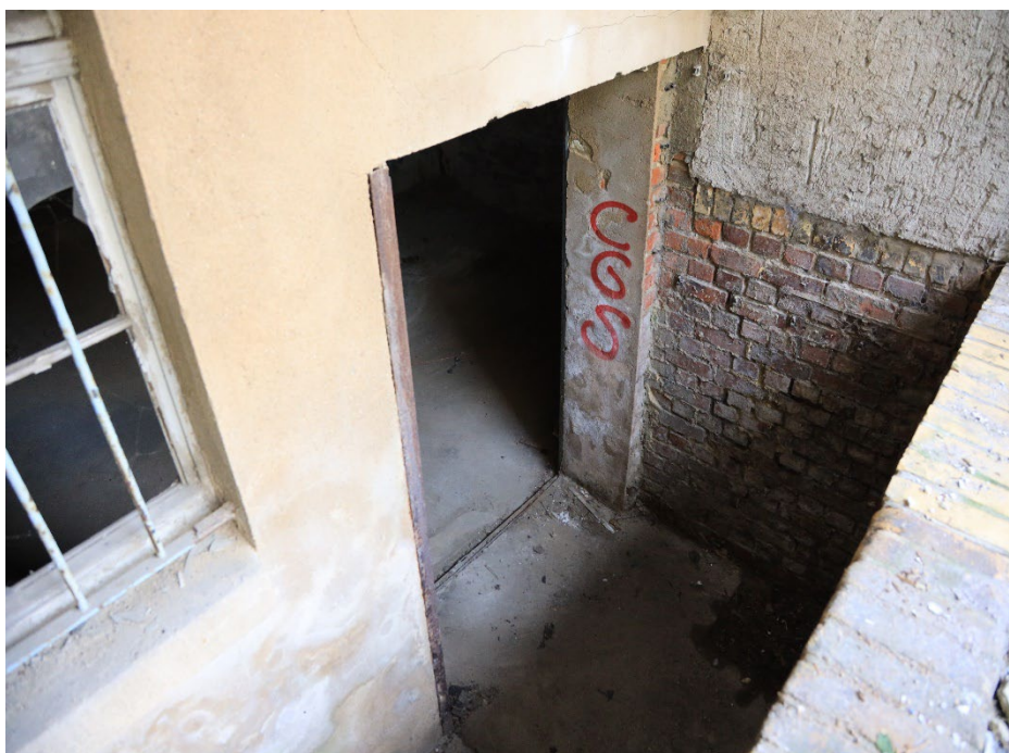
Abbildung 12: Zugang zum Kellergeschoss unter dem Hauptgebäude (10.11.2022).
