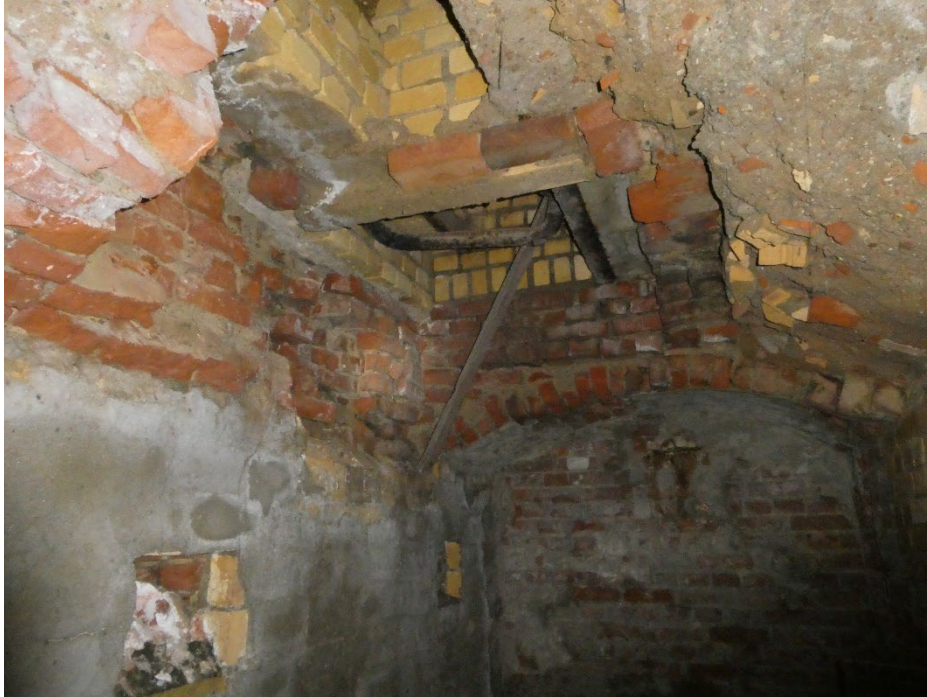
Abbildung 8: Kellerdecke mit Entlüftungsschacht (13.03.2024).
