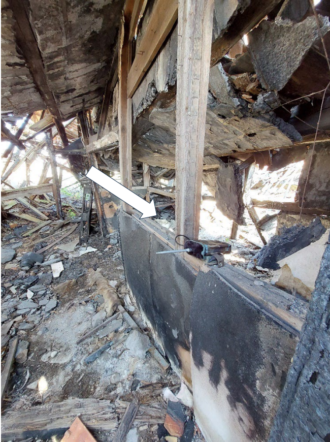
Abbildung 4: Zweiter Batcorder in einem Dachraum der der alten Emaillierfabrik (Pfeil).
