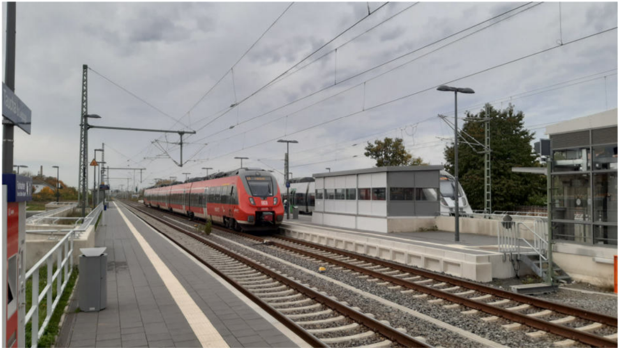
Abbildung: Lärmquellen des Schienenverkehrs: Eisenbahnstrecke Nr. 6360 Oberes Bild: in Richtung Osten, Unteres Bild: in Richtung Westen
